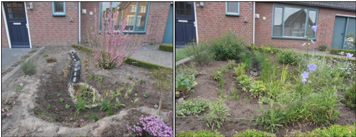
Figuur 75: Regenwater naar wadi in voortuin (links: aanleg wadi, rechts: wadi voltooid) (Bron: Van Eck, G.; [58])
