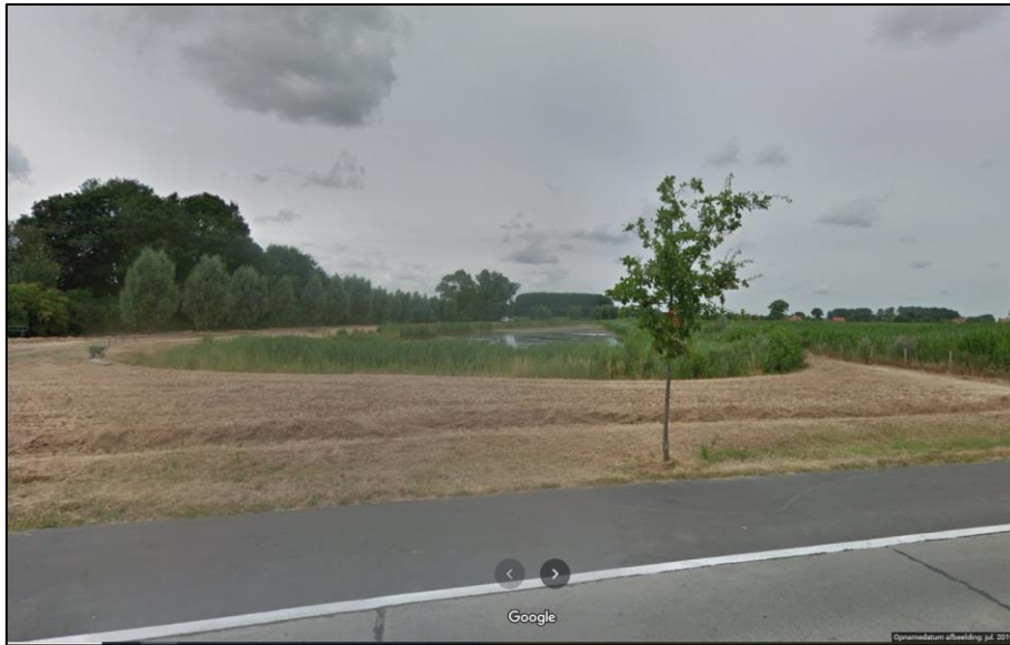
Figuur 86: Bufferbekken en GOG aan de Moorsledestraat, Moorslede (Bron: Google; [54])
